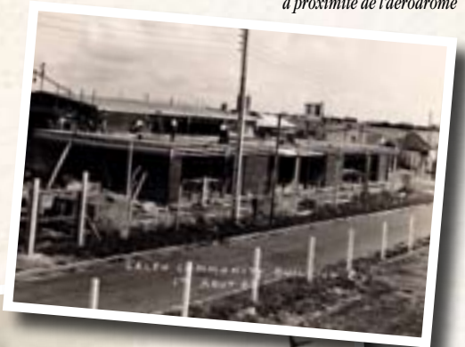
1960 - Construction d'entrepôts par les américains à proximité de l'aérodrome
