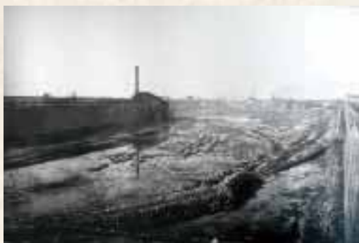
> Creusement du bassin de La Pallice en 1885.
