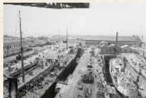
> Navires en réparations dans les deux formes de radoub devant les Chantiers Navals de La Pallice dans les années 60.
